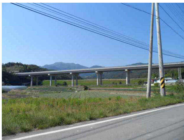
7공구 산성교 (7공구)
