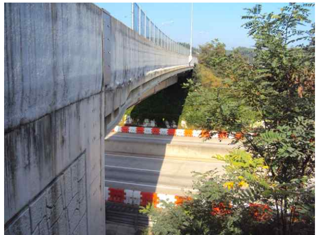
8공구 화산JCT RAMP-A교(8공구)
