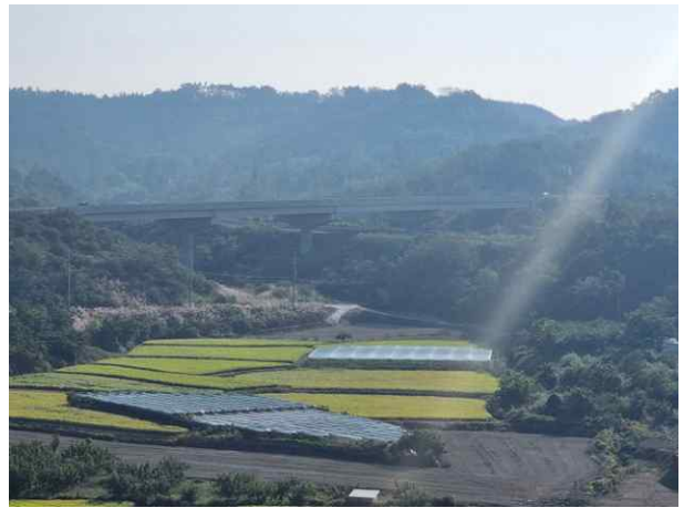
9공구 암기교 (9공구)
