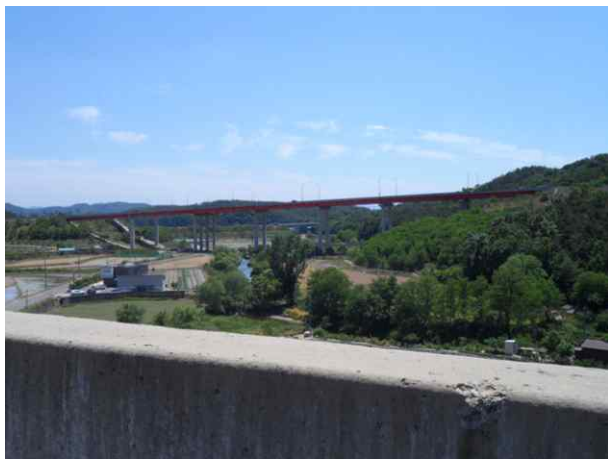
8공구 화산JCT RAMP-A1교(8공구)
