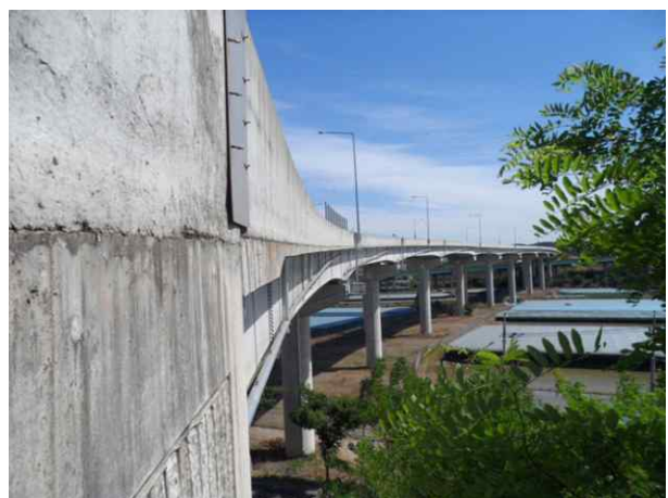
10공구 영천JCT Ramp-B교(10공구)
