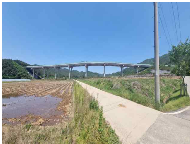
3공구 도개교 (3공구)
