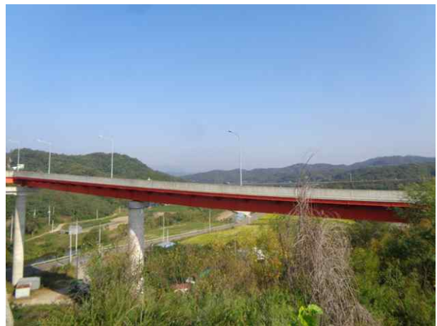
8공구 화산JCT RAMP-H교(8공구)
