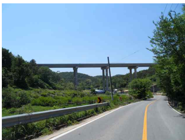
5공구 오실교 (5공구)
