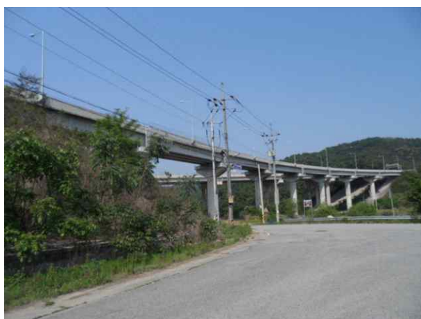
5공구 군위JCT R-C교 (5공구)
