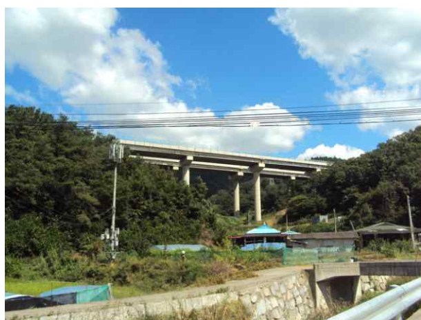
5공구 불당교 (5공구)
