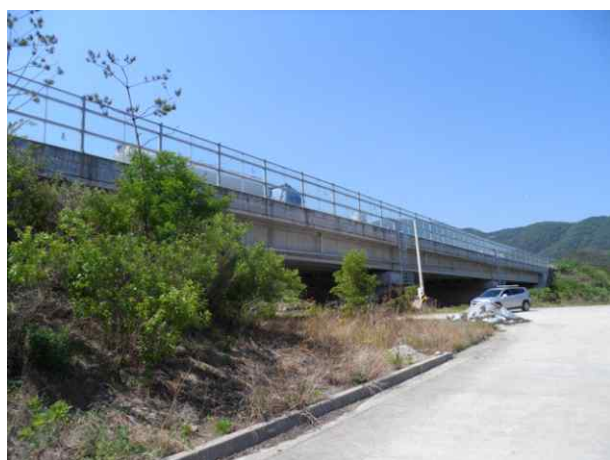
7공구 배골교 (7공구)
