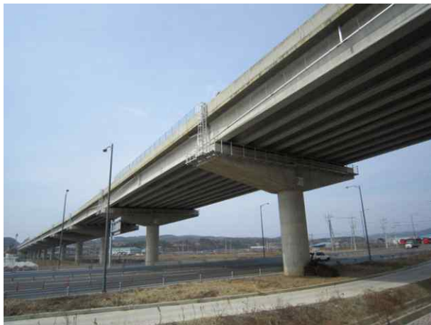
9공구 고현천교 (9공구)
