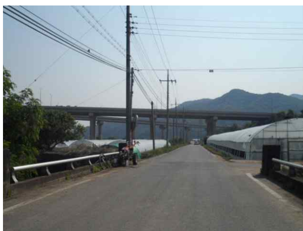
5공구 내리교 (5공구)
