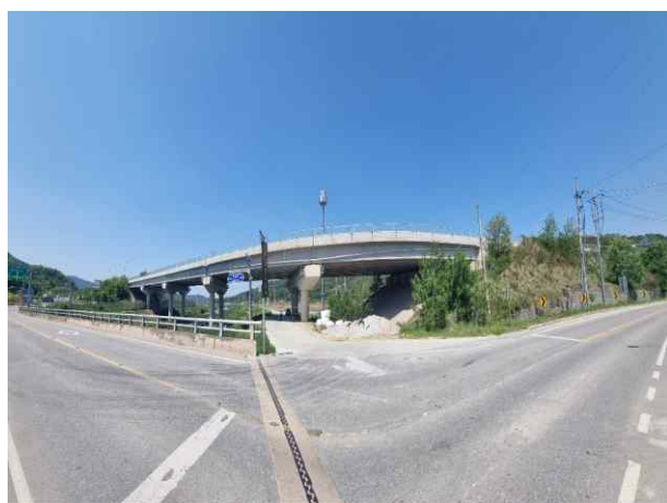
3공구 신계교 (3공구)
