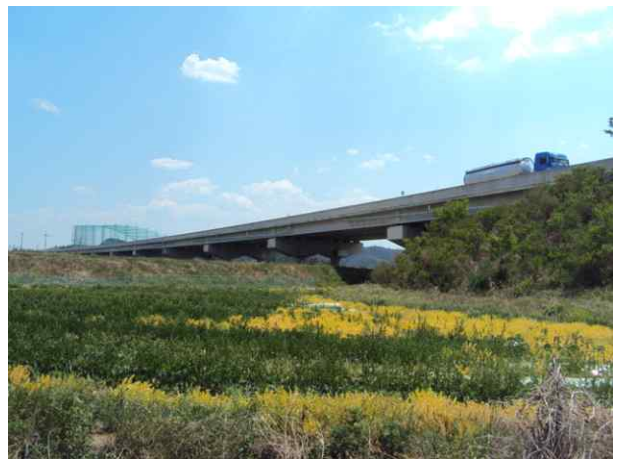
10공구 산하교 (10공구)
