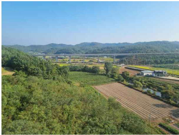
9공구 가래실교 (9공구)
