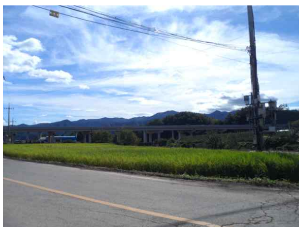
8공구 가천교 (8공구)
