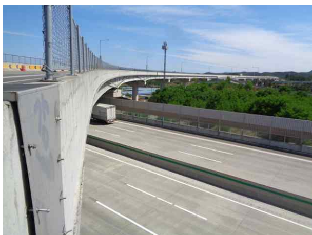
10공구 영천JCT Ramp-A교(10공구)
