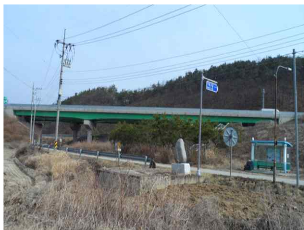
6공구 가호교 (6공구)
