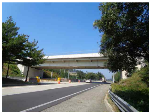
5공구 군위JCT R-A4교 (5공구)
