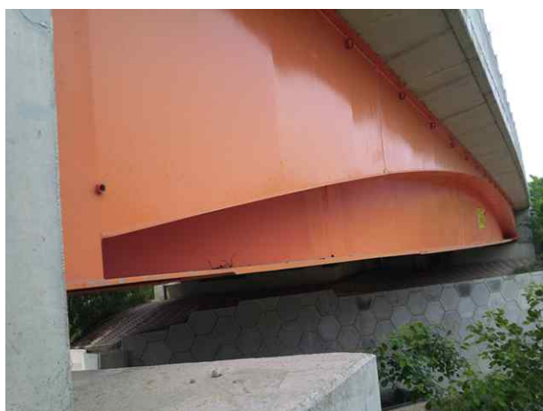
7공구 화남1교 (7공구)
