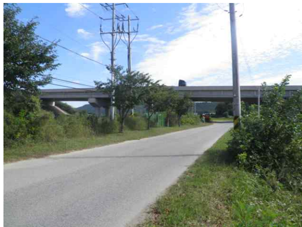
2공구 월가교 (2공구)
