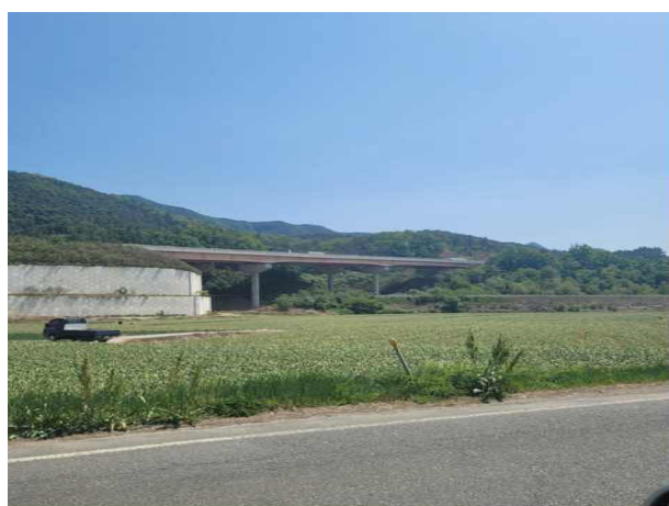
7공구 화남교 (7공구)
