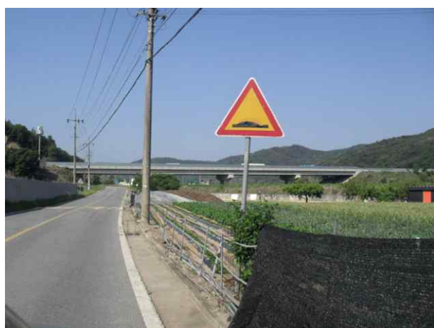
6공구 창기교 (6공구)
