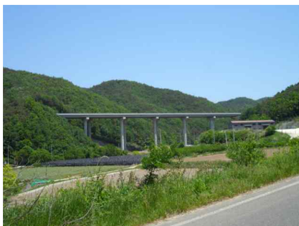
4공구 산호교 (4공구)
