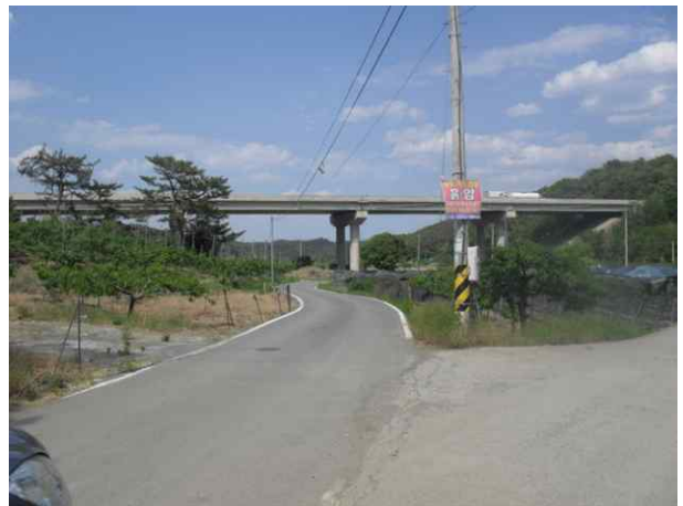
9공구 도림천교 (9공구)
