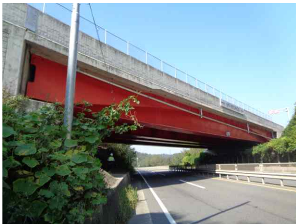
9공구 오미교 (9공구)
